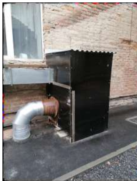
4.7. ИЗГОТОВЛЕНИЕ НАВЕСА НАД ВЕНТИЛЯЦИЕЙ:
