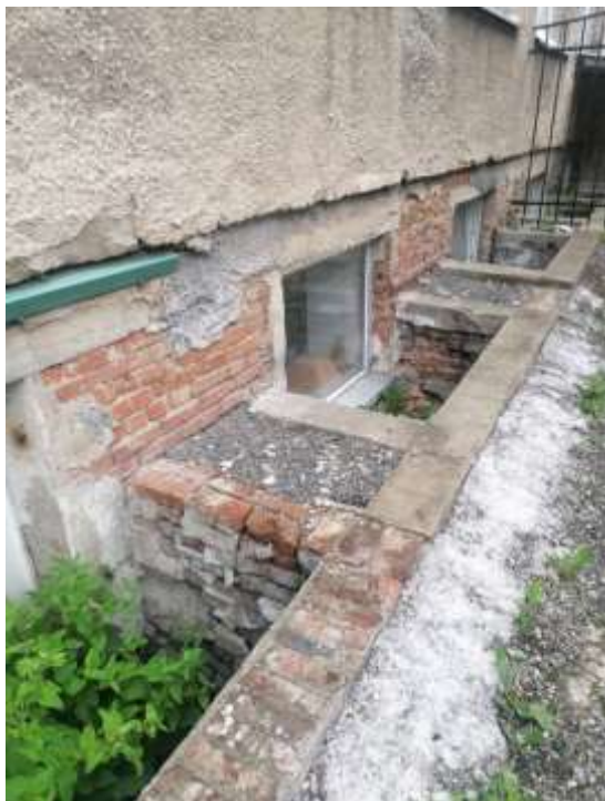
Фото до начала работ:
